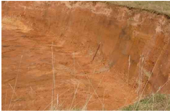
Beim Baggern im Frühjahr wird am Fuß der Sandwand immer noch eine flache Mulde ausgehoben
